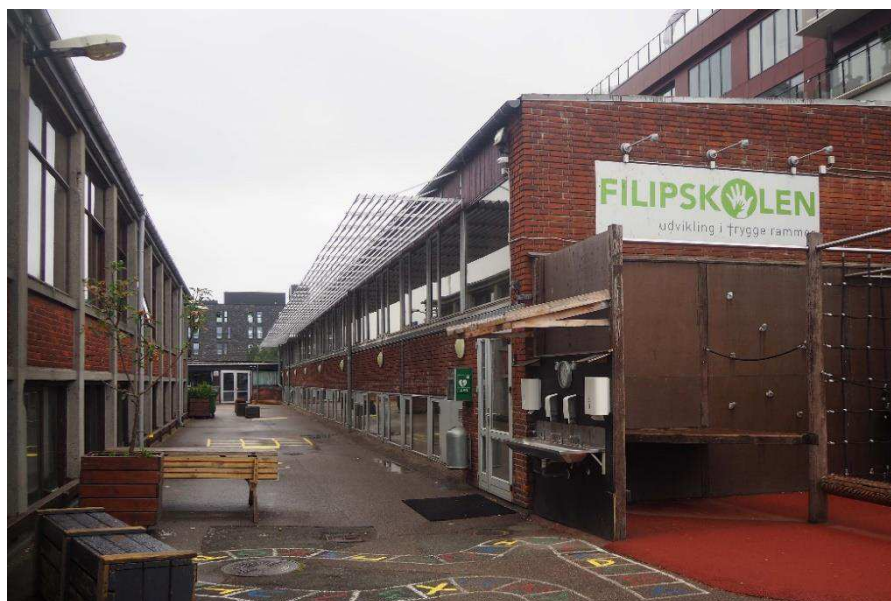
Amager Strandvej 124 bygning 1 og 3 set fra øst.
