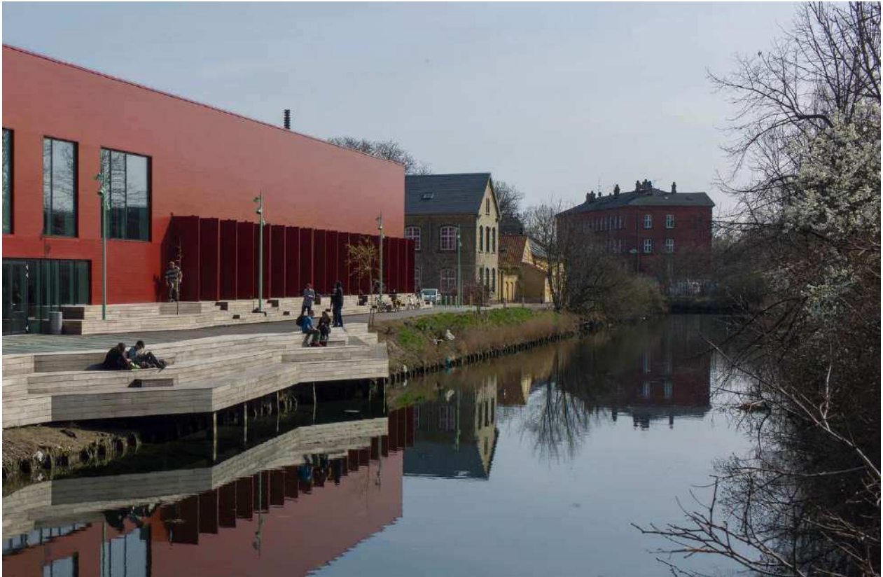
Eksisterende trappeophold ved Hal C
