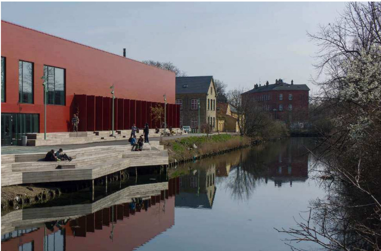
Eksisterende trappeophold ved Hal C
