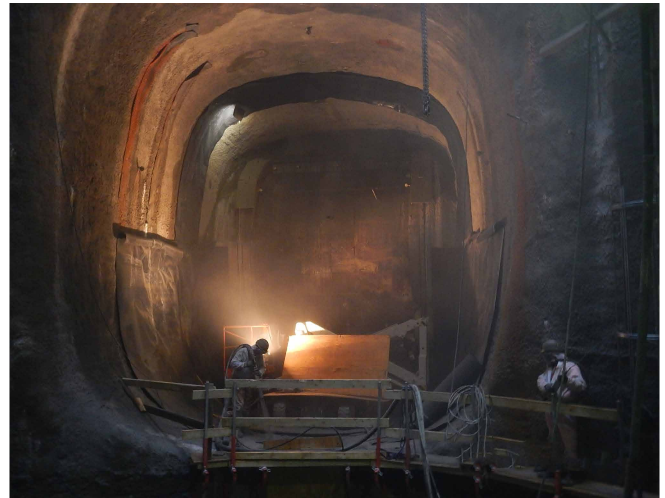
Redningsskakt i Krauseparken. I fremtiden vil der være hul helt ind til de to metrotunneler, den cylinderformede skakt er placeret imellem.
