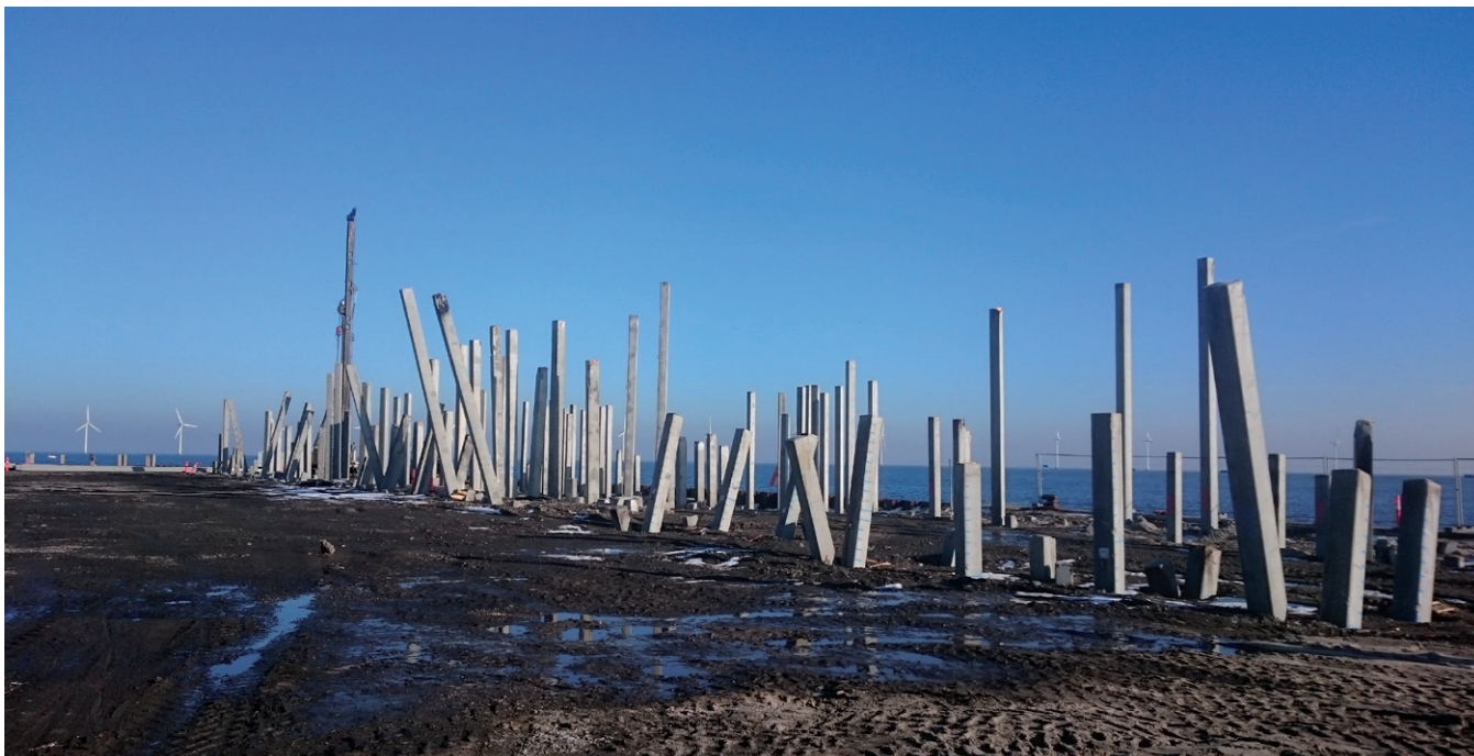
Flere end 6.500 pæle blev banket i jorden for at sikre fundamentet til den nye kraftværksblok på Amagerværket.
