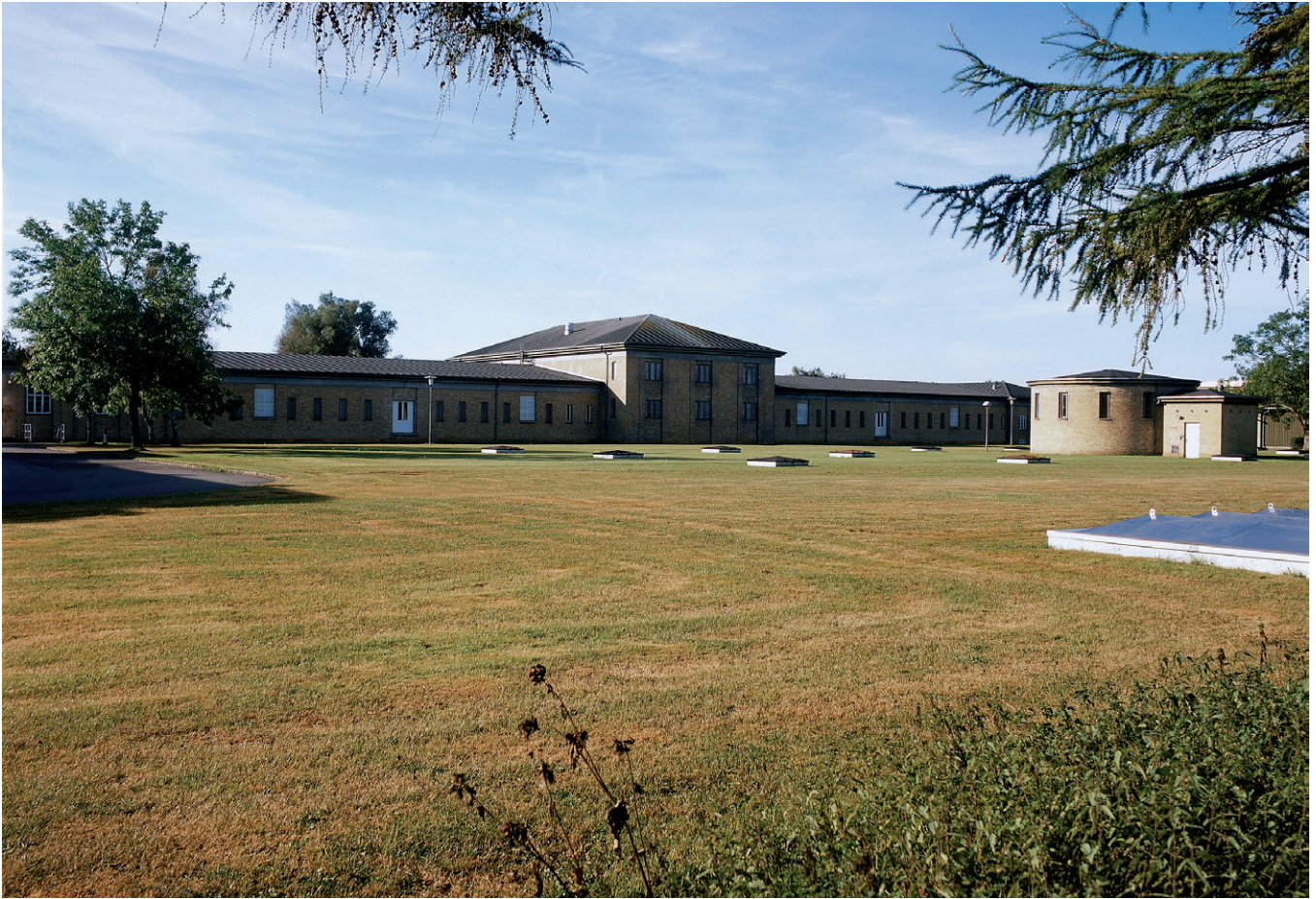
Projektet med at nybygge og modernisere Vandværket ved Søndersø startede i 2018.
