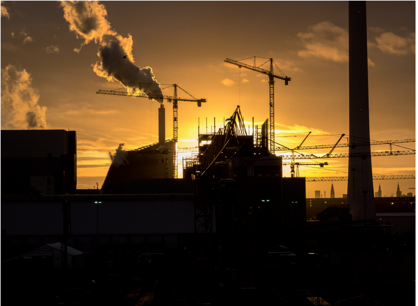
På Amagerværket er byggeriet af en ny kraftværksblok i gang – et byggeri som følger både budget og tidsplan.
