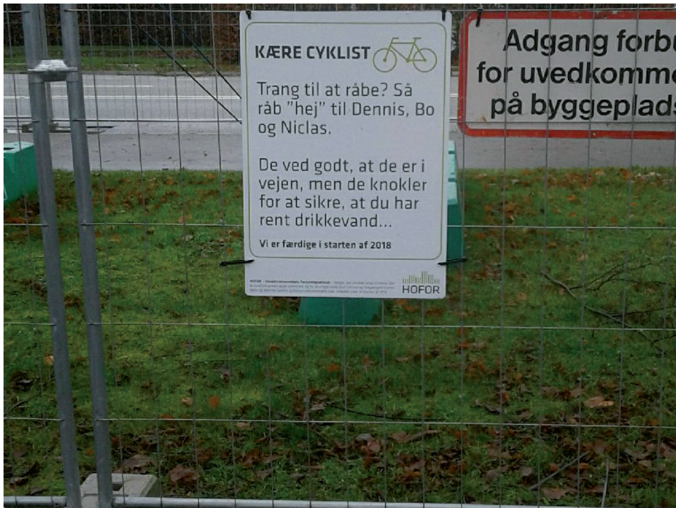
Kirkevej var et af de steder, hvor HOFOR renoverede drikkevandsledninger i 2017 – det betød, at fodgængere og cyklister skulle ud på en omvej.
