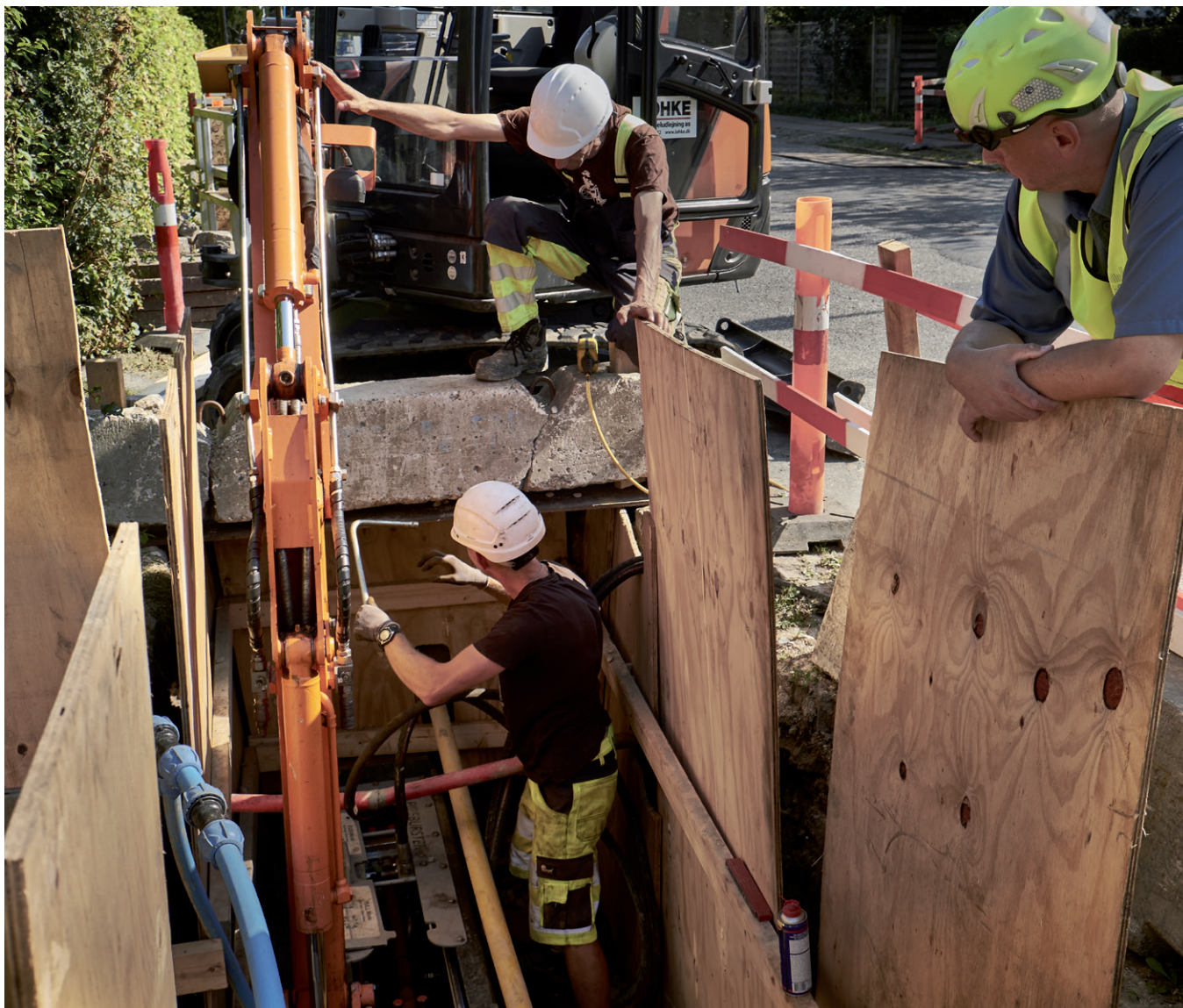
Renovering af drikkevandsledning på villavej i Hvidovre.
