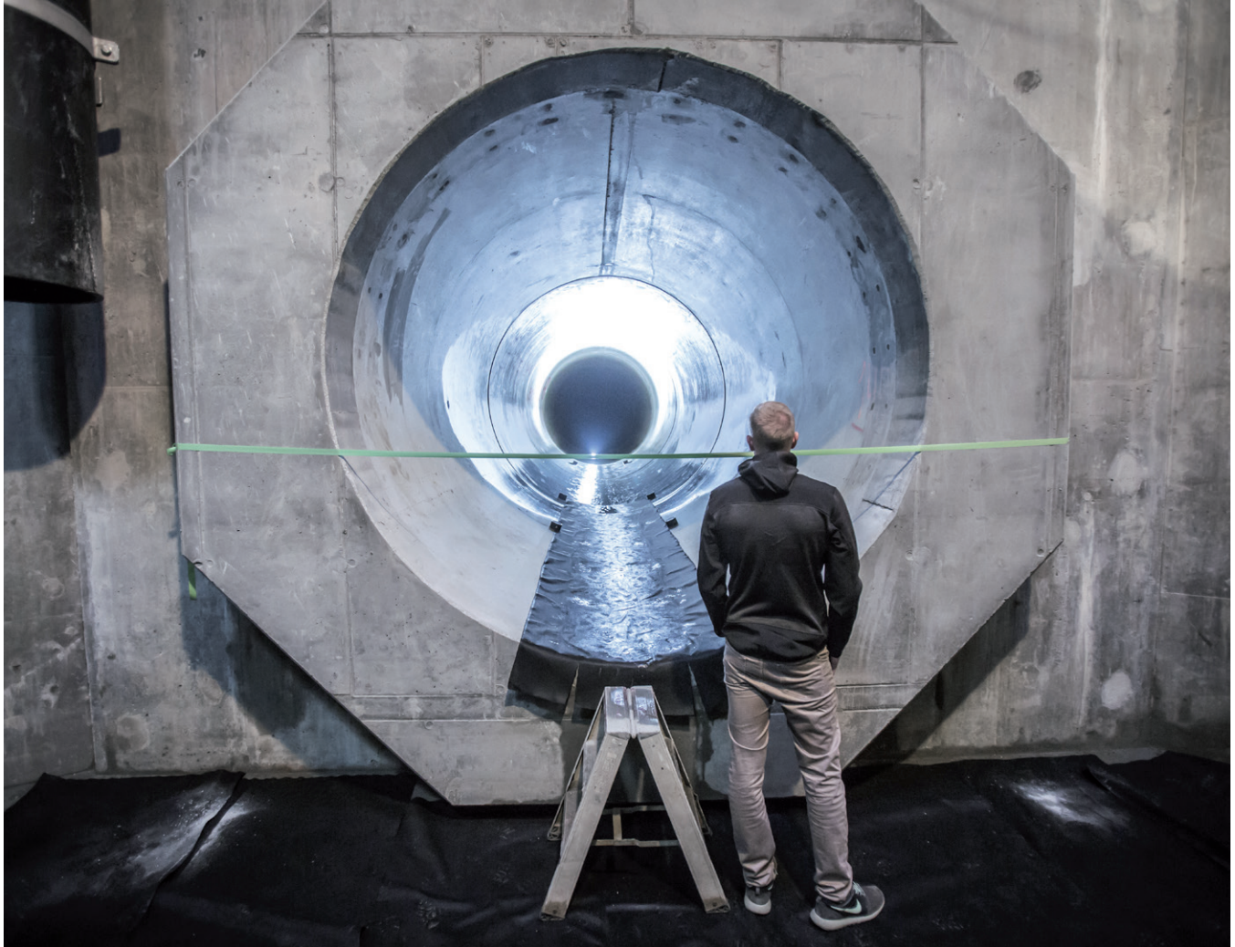
Regnvandstunnel på Østerbro blev indviet i august 2017.
