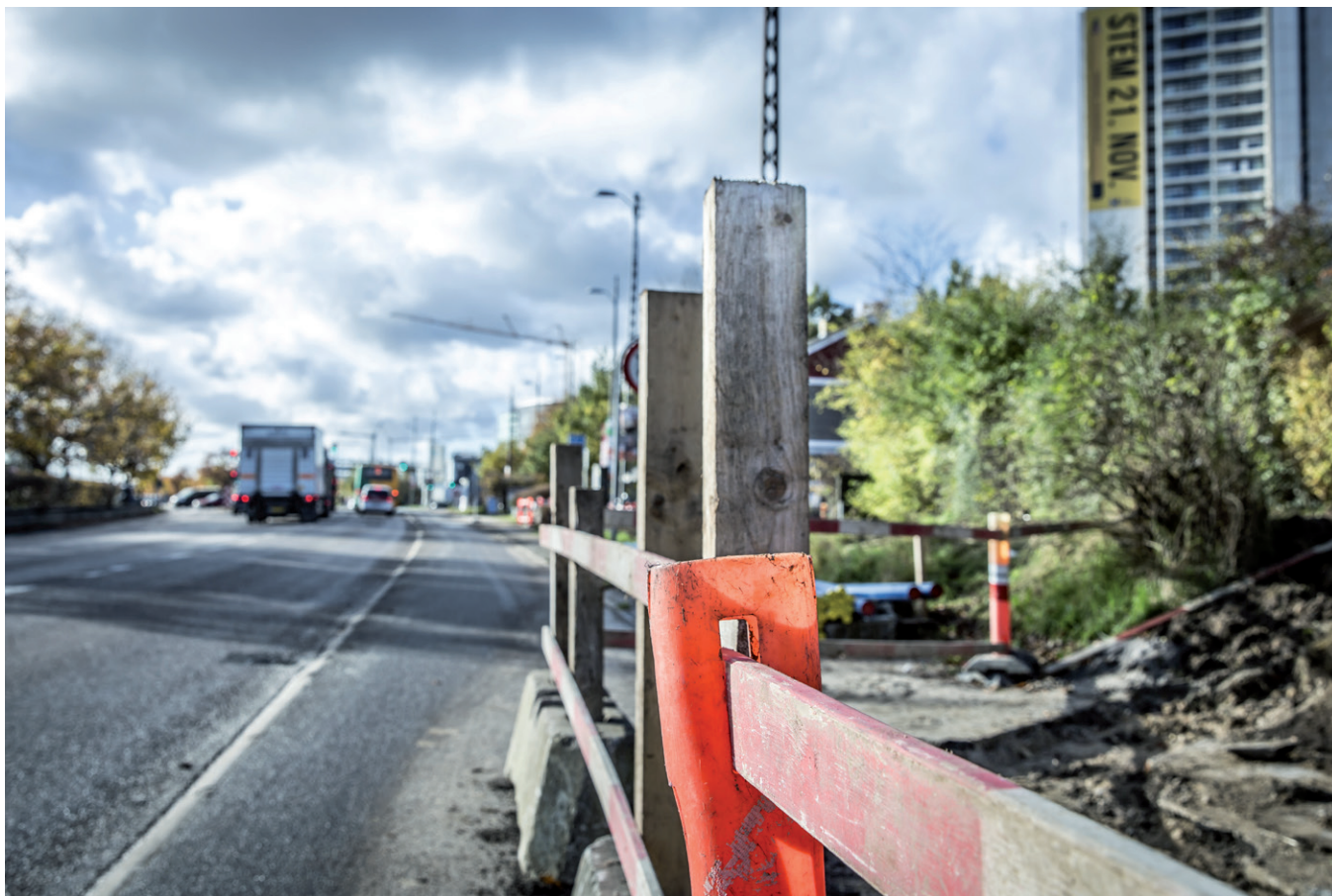
Renovering af drikkevandsledninger ved Ring 3 og Herlev Huse i 2017.
