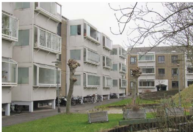
Haverummet i den nordlige karré med havestuer på de sydvendte facader
