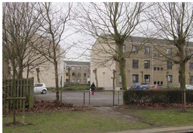
Den nordlige karré ud mod Vanløse Allé
