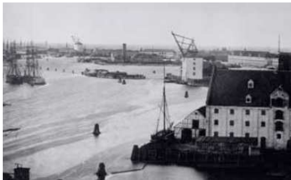
Ca. 1850 - Mastkranen var tidligere, med sin højde, et markant pejlemærke i havneløbet. med Badehallen Vene
