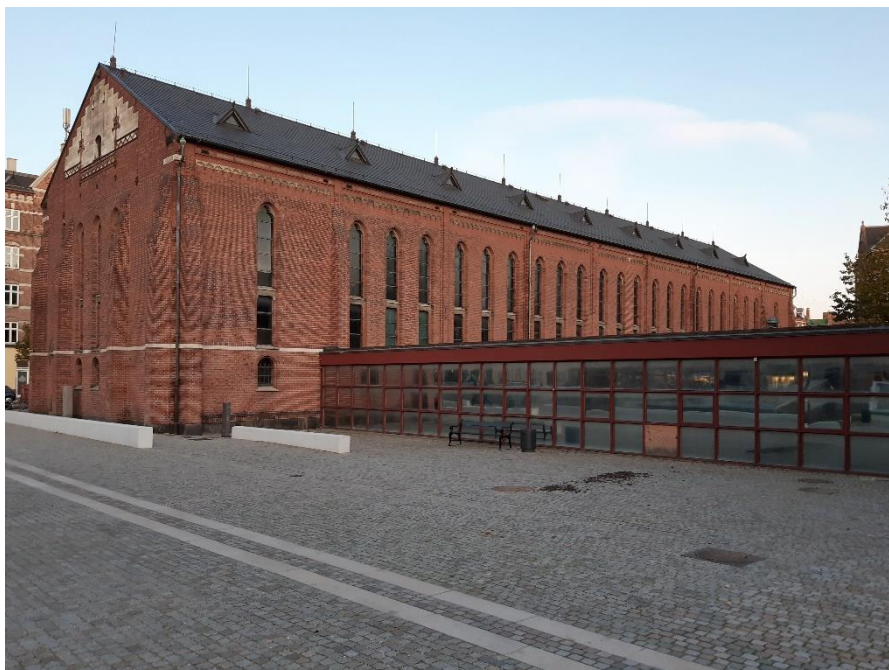
Arkivbygningen af Martin Nyrup (SAVE-værdi 3) i nationalromantisk stil, med den lave administrationsbygning af Eva og Niels Koppel, der senere er tilføjet.
