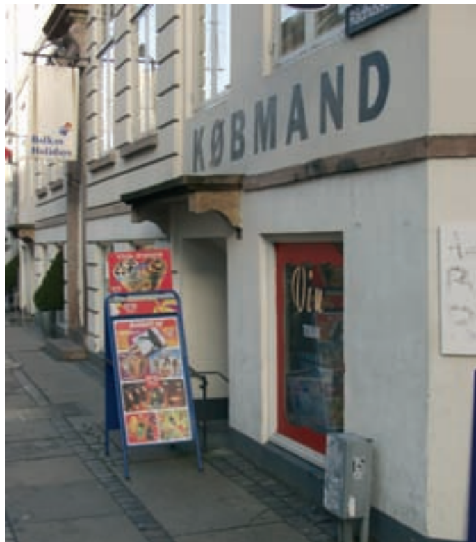
Skilteudstyr placeret på fortovsareal bør generelt begrænses.
