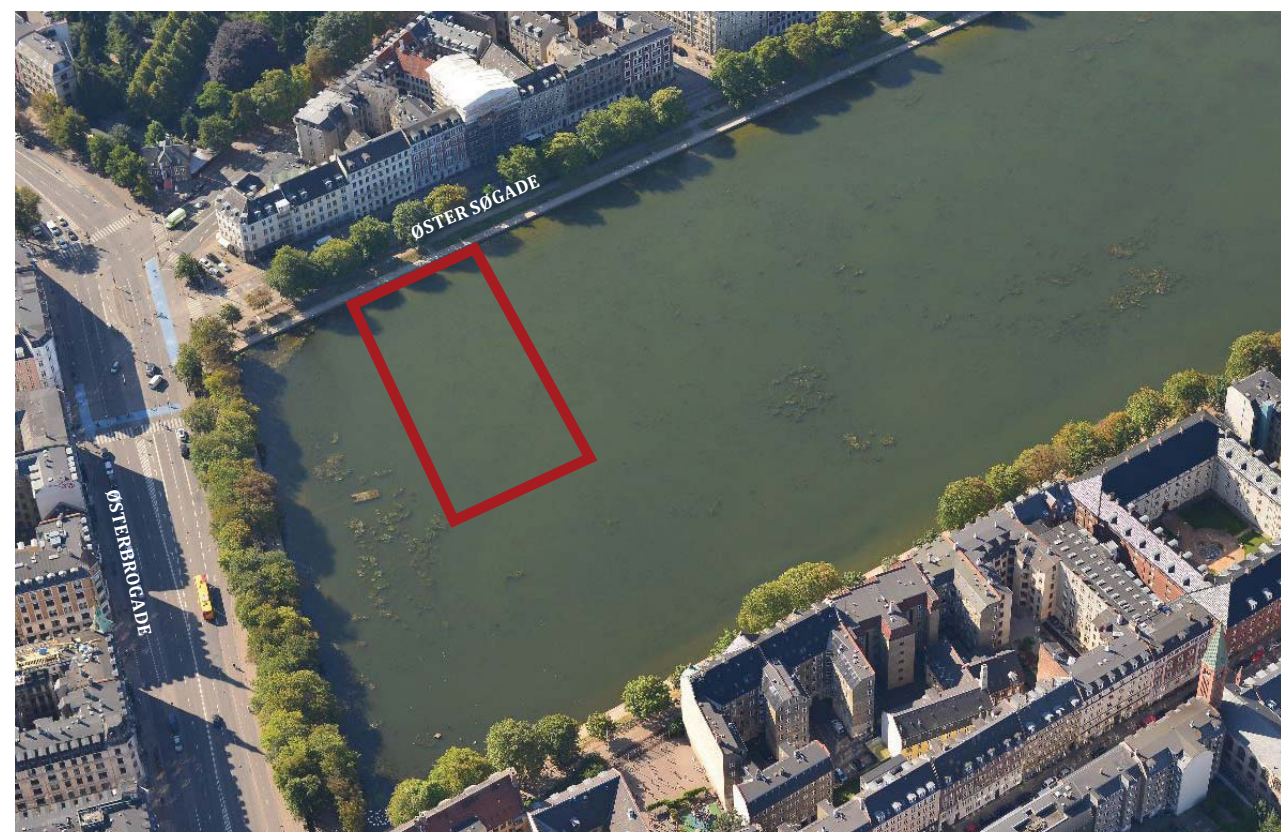
Luftfoto, Øster Søgade. Området, hvor metrokonstruktionen er placeret er markeret.
