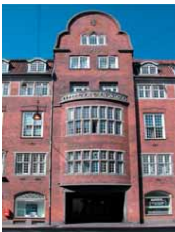
Eksisterende port Gl. Mønt 1 som fortsat skal fungere som adgangsvej for parkeringsarealerne i karreen.
