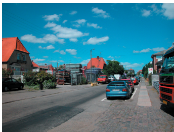
Kantstensparkering og de mange ind-/udkørsler fra virksomheder og villaeer begrænser oversigtsforholdene på vejene.
