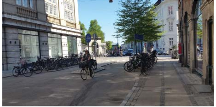
Eksempel på lokal indsnævring af kørebanen, som giver plads til træer og cykelparkering, Møntergade
