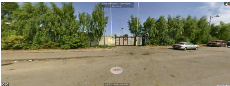
Figur 7-8 Eksempel på de lukkede områder ved Bådehavnsgade. På billedet ses indgangen til bildemonteringen. (COWI street view, Maj 2018).
