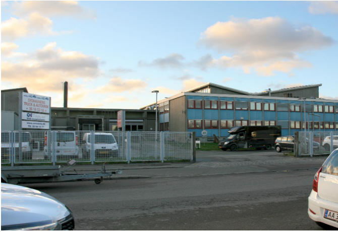
Den vestlige side af Bådehavnsvej er i dag præget af store erhvervsbygninger.
