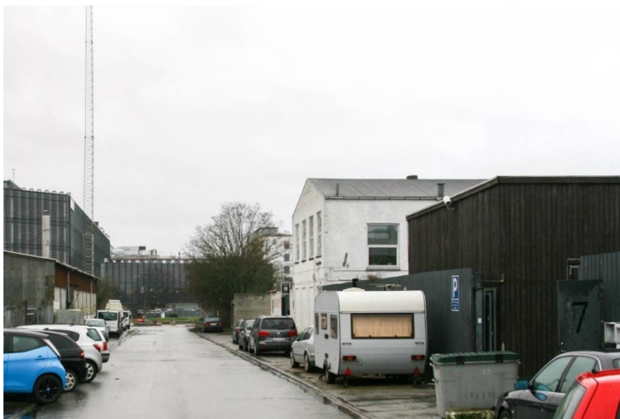
Den SAVE-registrerede bygninger på Yderlandsvej 5 er bevaringsværdig i SAVE klasse 5, hvilket svarer til mellem bevaringsværdi. Opført i 1949.
