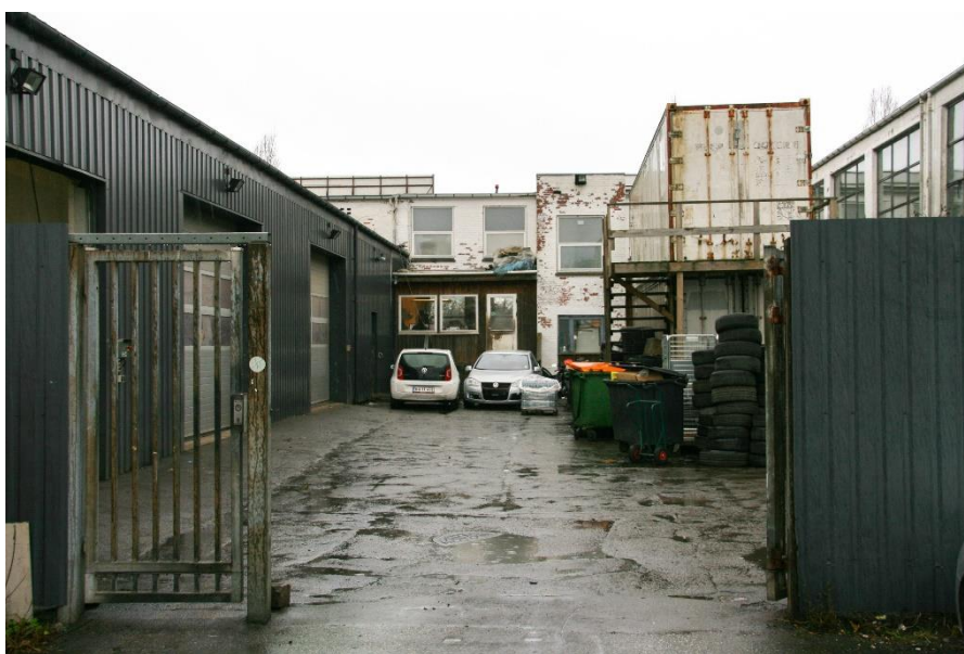
Den SAVE-registrerede bygninger på Yderlandsvej 5 er bevaringsværdig i SAVE klasse 6, hvilket svarer til mellem bevaringsværdi. Opført i 1949.
