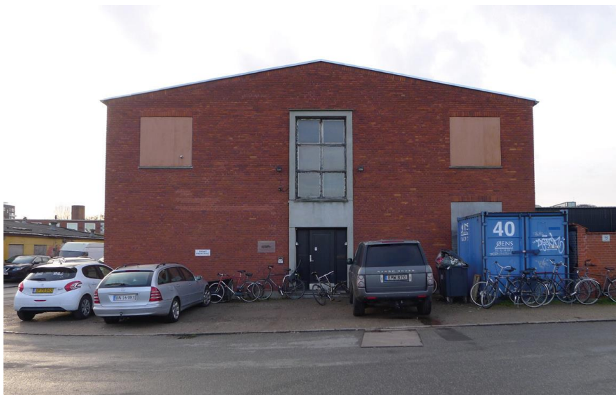
Bygningen på Yderlandsvej 14 er ikke registreret i SAVE registreret, men ønskes delvist bevaret i en ny lokalplan. Opført i 1951.
