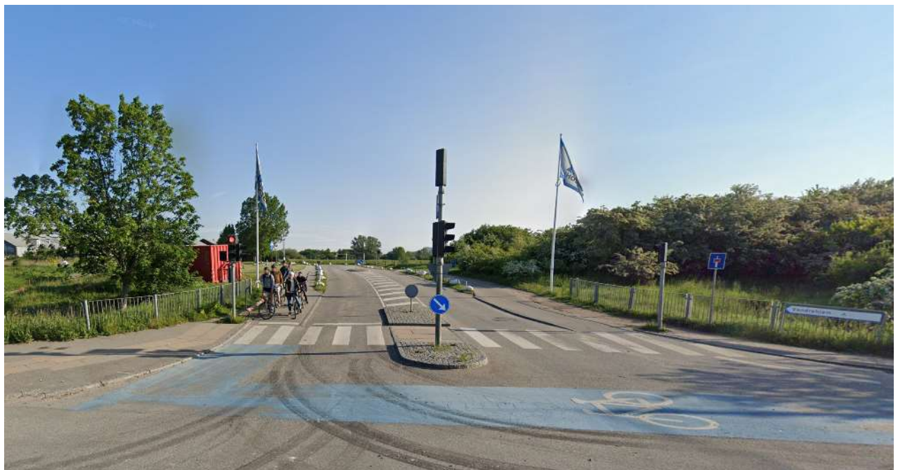
Figur 8.3 Supercykelstien ved indkørslen til projektområdet i krydset Vejlands Allé/Center Boulevard (set fra syd).
