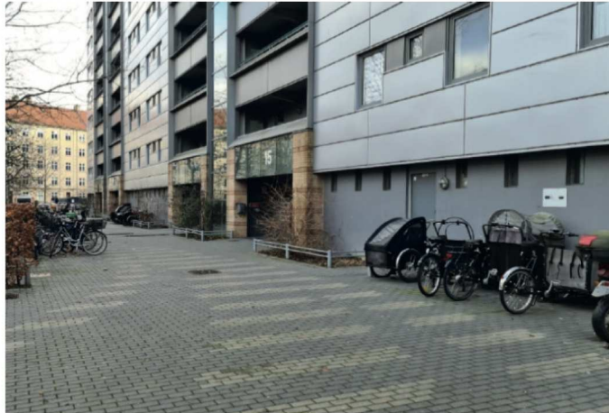
Billede af stueetagerne i dag. Åbning af stueetagerne kan bidrage med nye aktiviteter i området.
