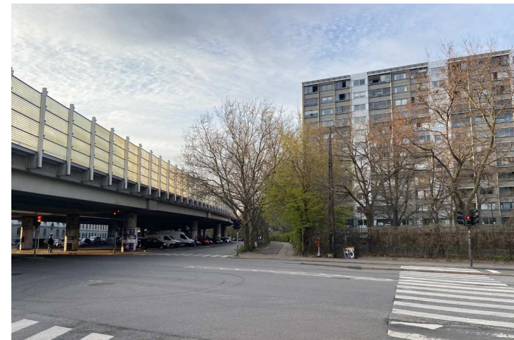
Lundtoftegadebebyggelsens højhuse ligger tæt på buen.
