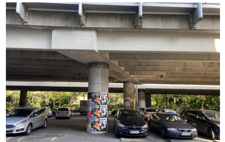
Parkering under den sydlige del af Bispeengbuen.
