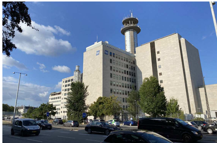
Telefonhuset opført i 1950'erne set fra Ågade.
