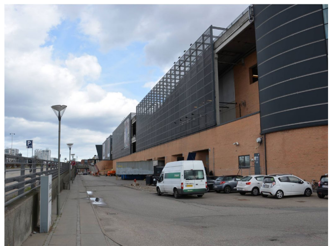
Fisketorvets nuværende facade mod Kalvebod Brygge med vareindleveringsområdet.
