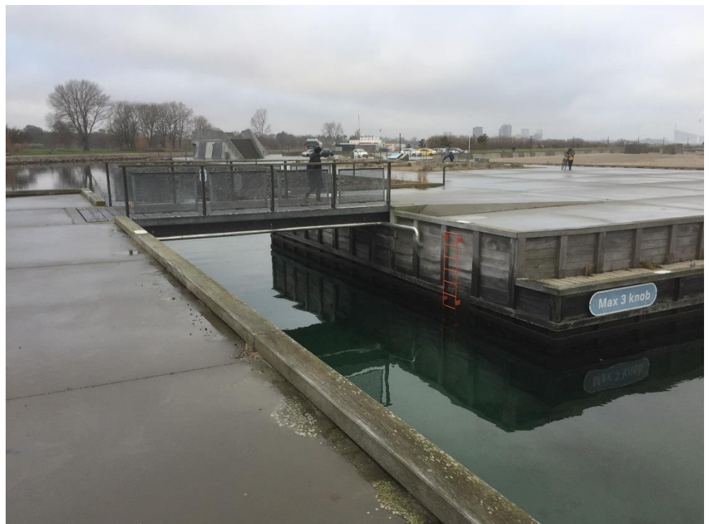
Figur 7-7 Amager Strandpark, sydlige indsejling/indløb til kanalen (foto, OJJ, COWI 28/12 2016).
