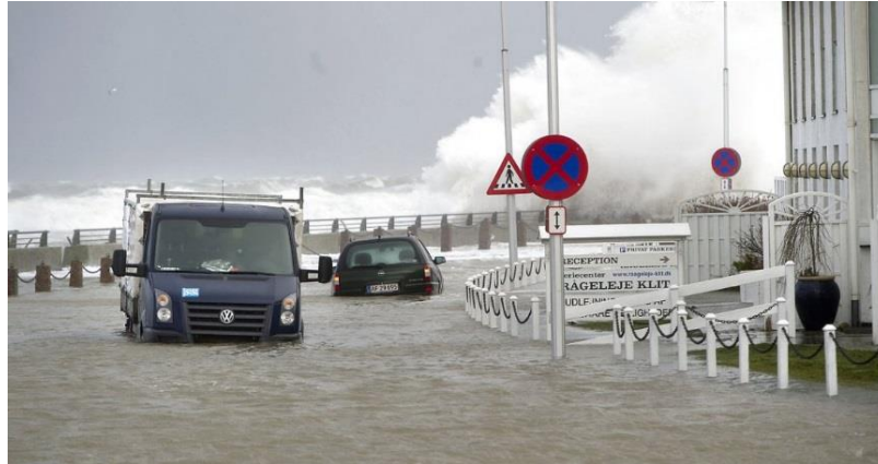
Figur 9-6 Rågeleje strandvej på Nordkysten af Sjælland under stormen, Bodil (DK) og med oversvømmet kystvej på grund af bølgeoverskyl.
