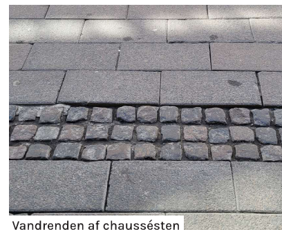
Vandrenden af chaussésten
