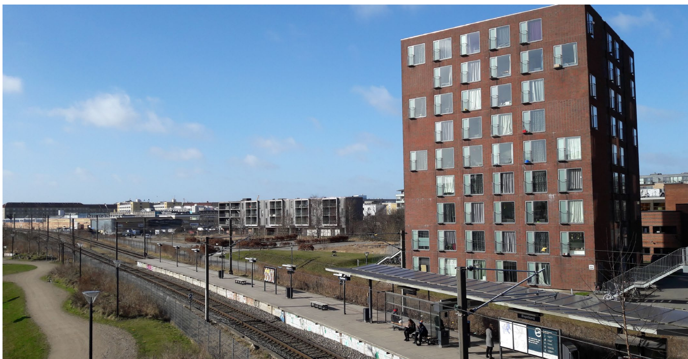
Lokalplanområdet set fra Bispebjerg St. med udsigt til Bispebjerg Kollegiet, det ubebyggede areal og KAB' boligbebyggelse samt Nørrebro By-center
