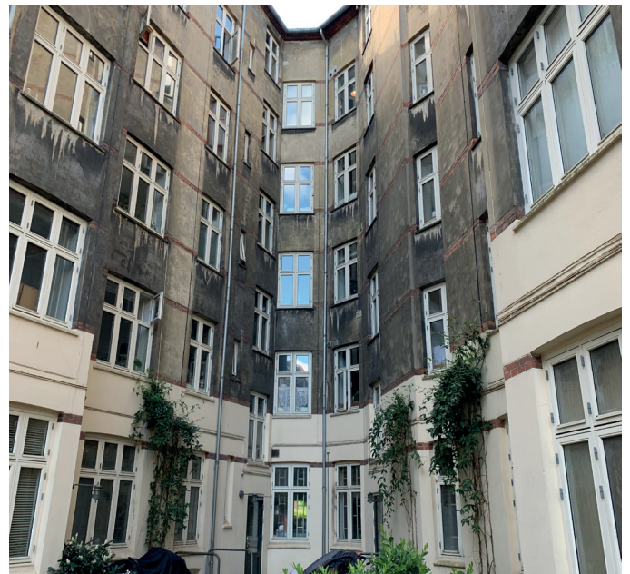
Gårdfacade renoveres og vinduerne udskiftes.
