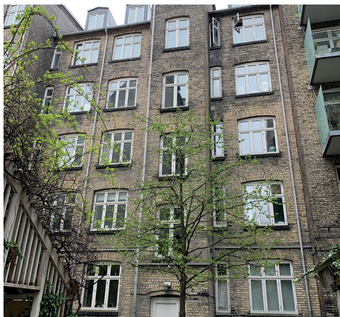
Gårdfacade isoleres, og vinduer udskiftes til franske altaner.
