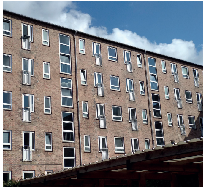
Gårdfacade efterisoleres med løsning fra Klimakarré.
