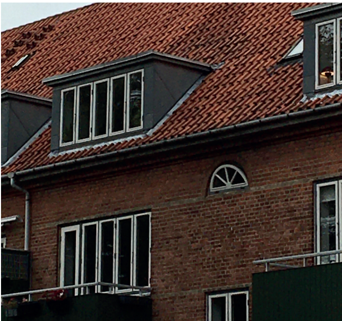
Der integreres solceller i taget og vinduer istandsættes.
