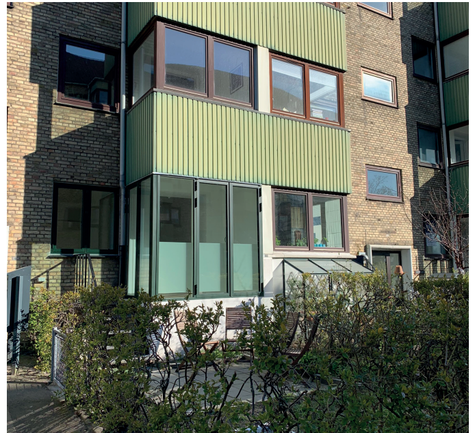
Uisolerede karnapper ombygges og får mere dagslys.
