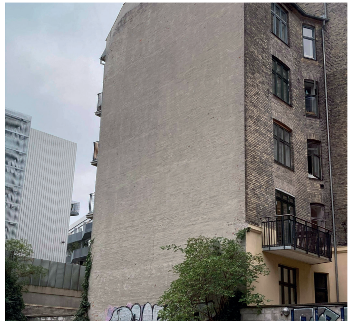
Ejendommens kolde gavle efterisoleres.
