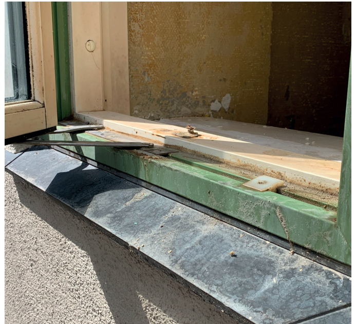
Nedslidte vinduer udskiftes til nye trævinduer.
