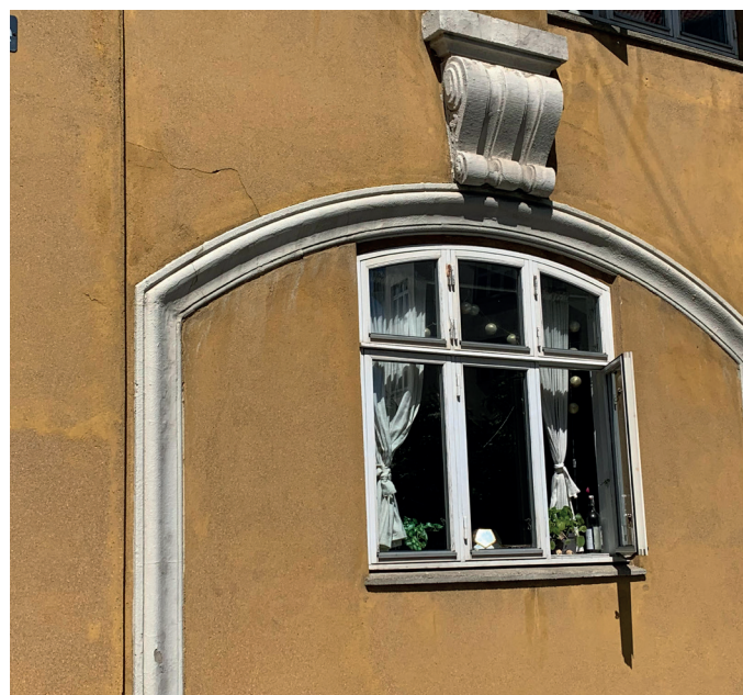
Vinduer udskiftes og facader renoveres.
