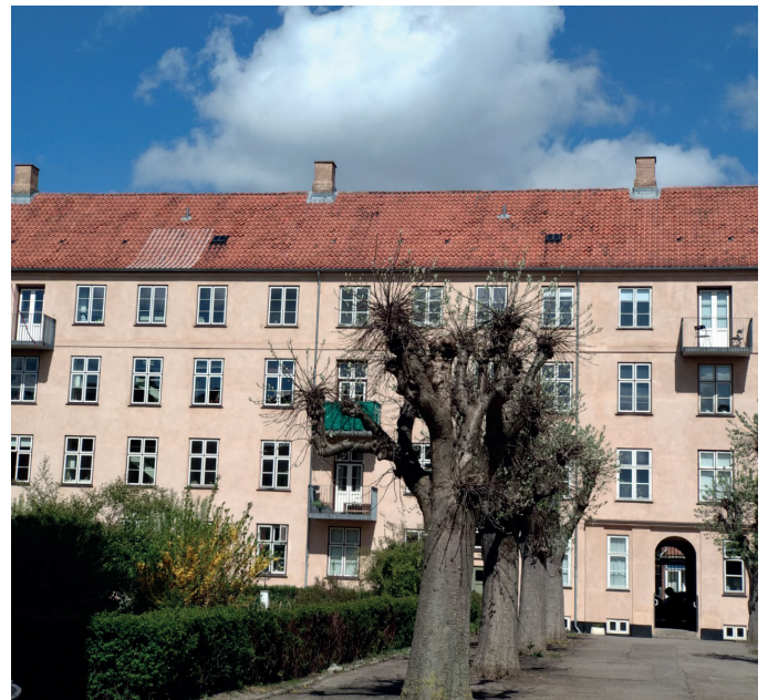
Nedslidt tegltag udskiftes og der opsættes røde solceller.
