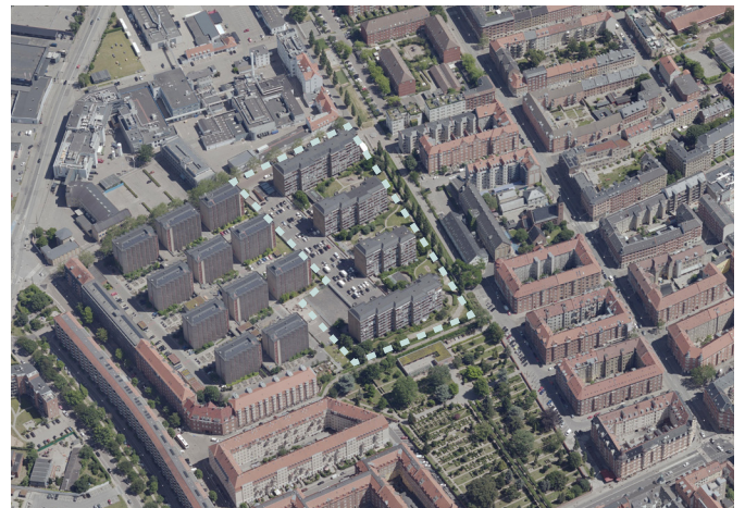
Luftfoto af Prags Boulevard.
