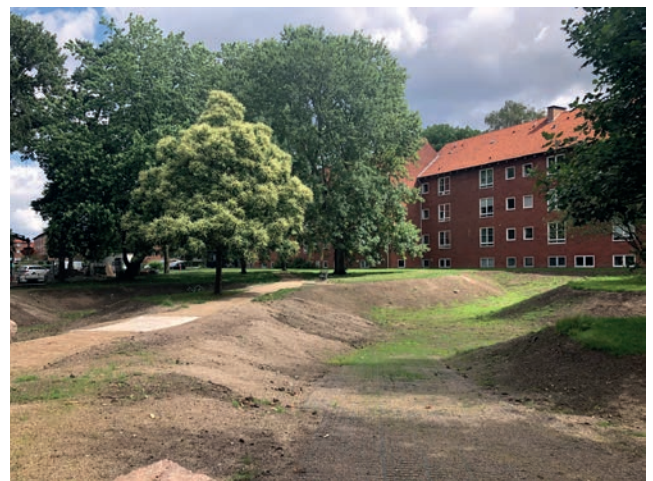
↑ Anlægsarbejder i Husum Vænge
