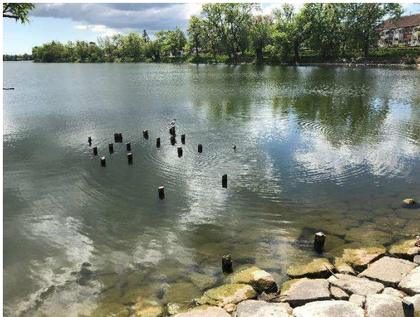
Figur 6 Der har tidligere været anlagt træbroer i Damhussøen ud for dæmningen
