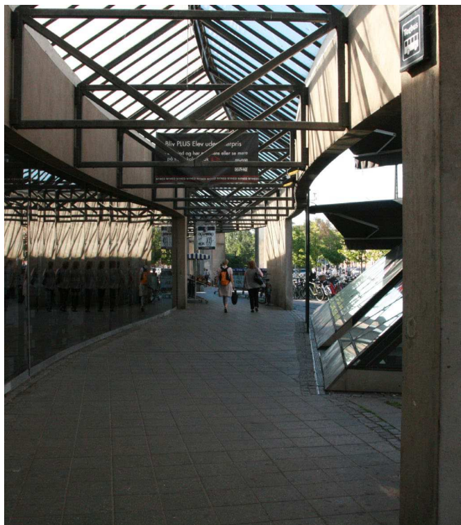
Eksisterende arkade langs Irma og Spejder Sport. Arkaden nedrives i forbindelse med det nye projekt.
