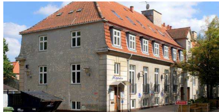
Det nuværende Kulturhuset Pilegården rummer en sal, en café samt møde- og aktivitetslokaler af varierende størrelse. I kælderen findes motionsrum samt keramikværksted, som de nuværende brugere håber på kan bevares, efter kulturhusets flytning. I haven bag Rytterskolen findes en petanquebane, en lille scene og overdækkede siddepladser. Haven bruges i dag bl.a. til jazzkoncerter og af foreningen Rollespilsfabrikken, der har hjemsted i en villa ved Pilegården. (foto: Lokalhistorisk Selskab For Brønshøj Husum og Utterslev)
