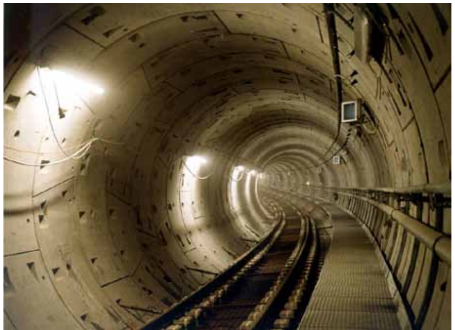
Figur 4.4 Færdigmonteret tunnelrør med spor, nødfortov, kørestrøm og andre mekaniske og elektriske installationer.
