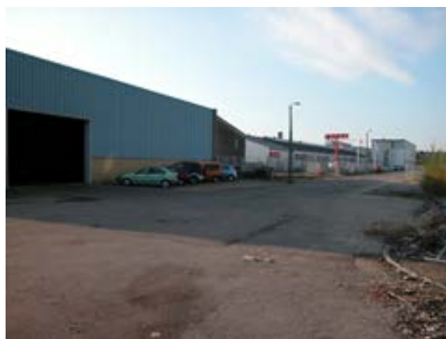
Billedet viser eksisterende bebyggelse på Østre Teglade.
