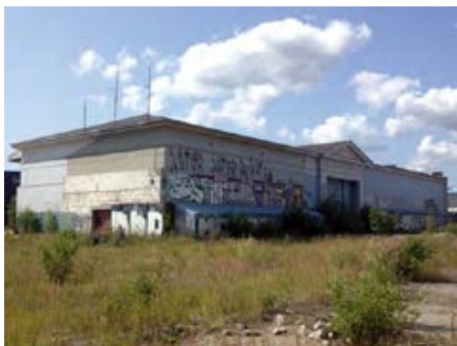
'Specialstålhallen' set fra Vasbygade
