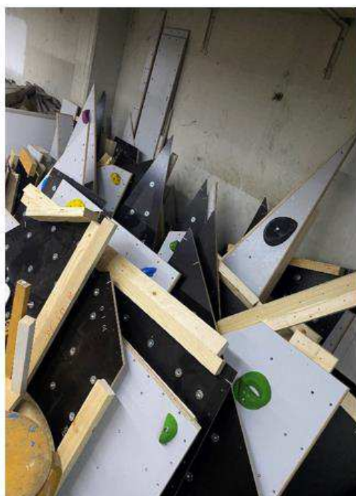
Fig. 3 - Klatrevæggen venter på nyt liv i kældereren
