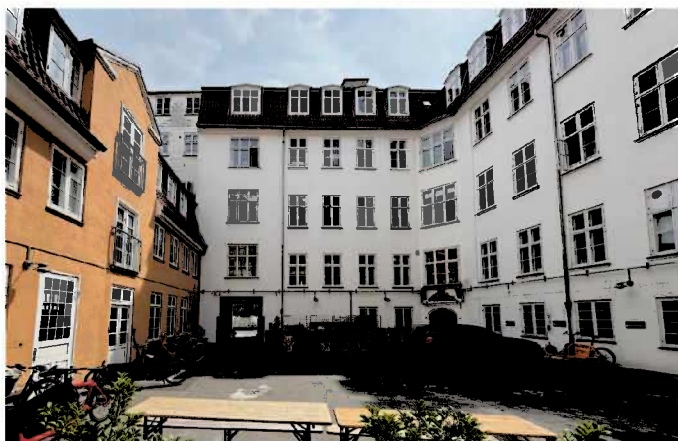
Billede fra stedet – Eksisterende gårdtrum og bygninger. Blik mod syd. De hvide bygninger er nr. 32. Gul bygning er nr. 30A-B.
