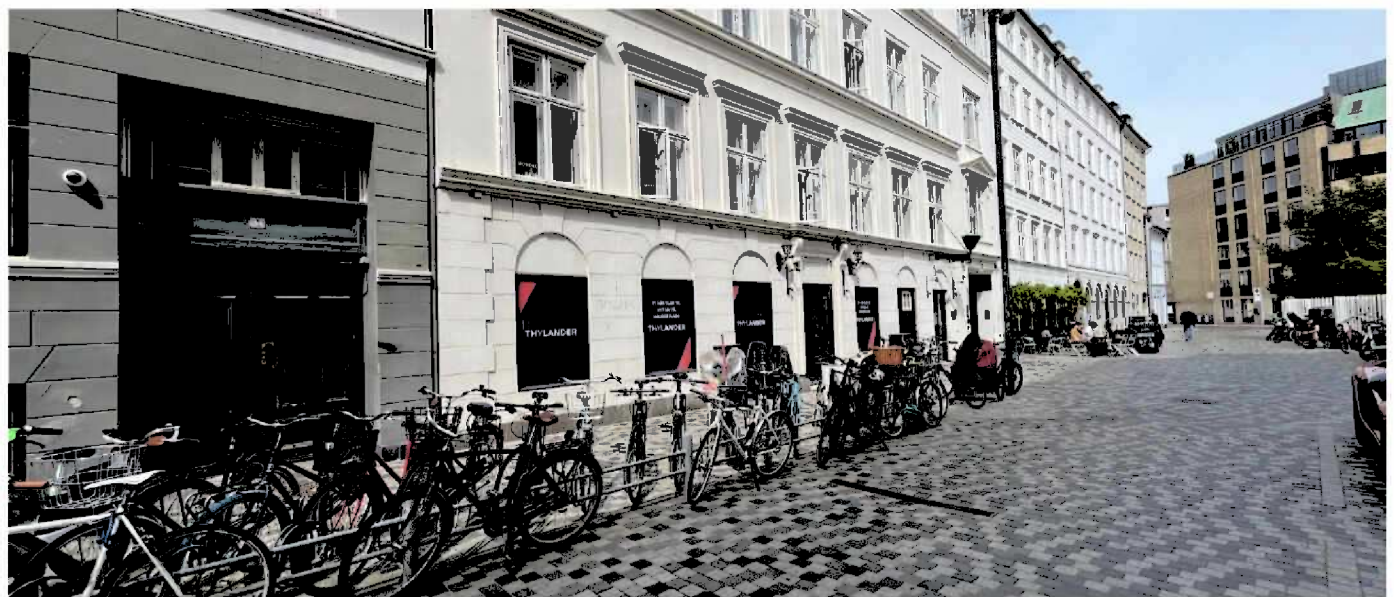
Billede fra stedet – Eksisterende facaderække mod Hausergade og Hauser Plads. Blik mod øst. Bygningsnumre fra venstre: Grå bygning er Hausergade nr. 34, hvid bygning er Hauser Plads nr. 32, hvid bygning er Hauser Plads nr. 30, hvid bygning er Hauser Plads nr. 28, sandfarvet bygning er Hauser Plads nr. 26, lysegrå bygning er Hauser Plads nr. 24.
