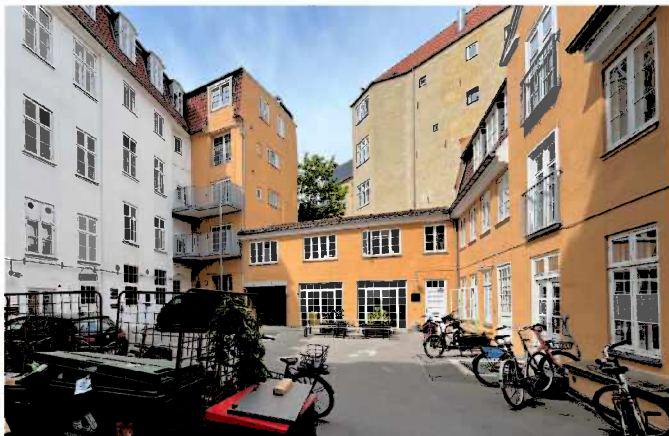
Billede fra stedet – Eksisterende gårdtrum og bygninger. Blik mod nord. Hvid bygning er nr. 32. Høj gul bygning til venstre er nr. 32A. Lav gul bygning er nr. 30C. Mellem-høj gul bygning er nr. 30A-B.
