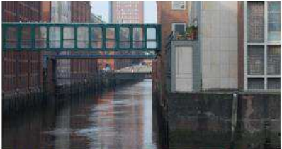
HAMBORG HAVN, Bygningerne danner kystsikring
