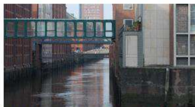
HAMBORG HAVN, Bygningerne danner kystsikring
