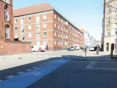
Kaotisk kryds hvor Griffenfeldsgade møder Korsgade
