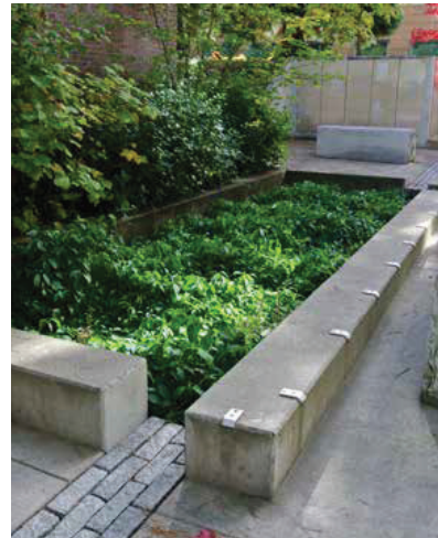
Grøn regnvandsforsinkelse på plads i Portland, USA
