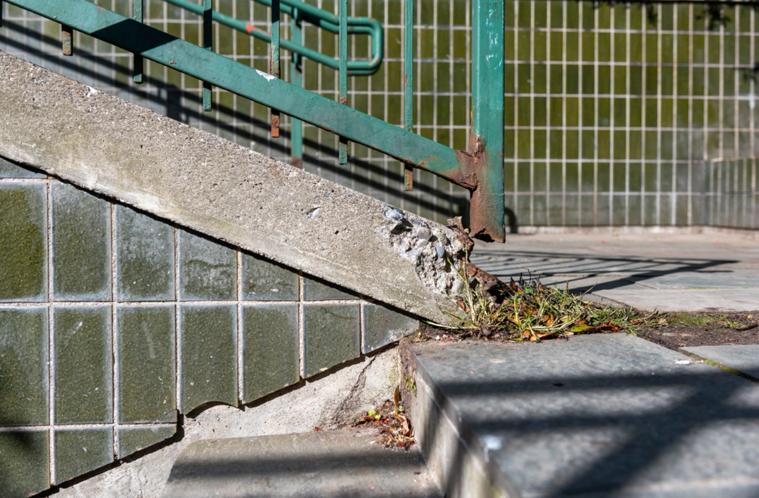
GANGTUNNEL UNDER JAGTVEJ V. STEVNSGADE
