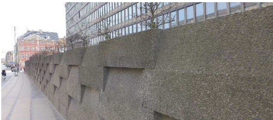
Ørkenfortets plint. Plinten er betonelementer, men omhyggeligt udformet så den fremstår monolitisk. Formen er særegen og understreger plintens tyngde. Den er tung og lukket, så den fremhæver overbygningen glatte, lette karakter. Den oprindelige hovedtrappe har tidligere skabt en oplevelsesrig pause i den lange lukkede forløb.
