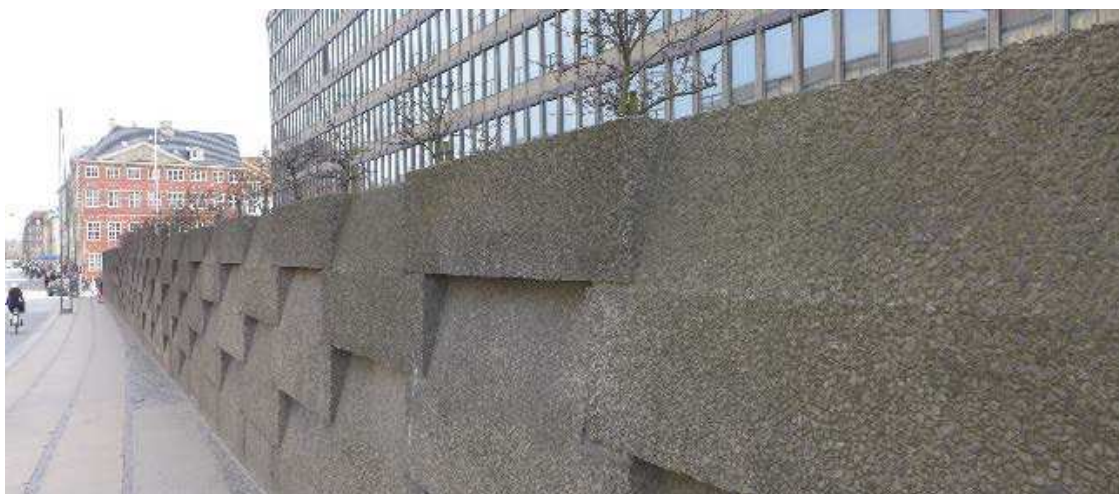
Ørkenfortets plint. Plinten er betonelementer, men omhyggeligt udformet så den fremstår monolitisk. Formen er særegen og understreger plintens tyngde. Den er tung og lukket, så den fremhæver overbygningens glatte, lette karakter. Den oprindelige hovedtrappe har tidligere skabt en oplevelsesrig pause i den lange lukkede forløb.
