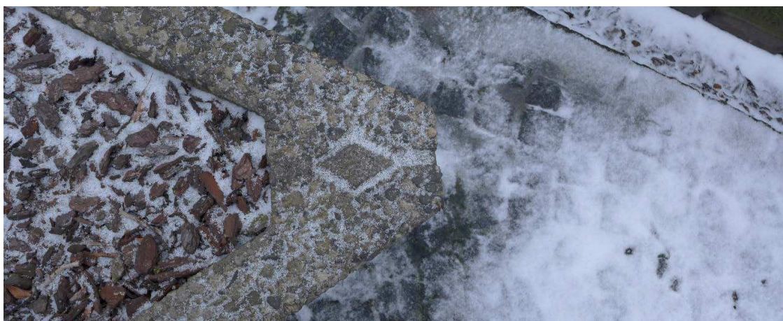
Plantekasserne i samme søstensbeton som facaderne. Kasser er fint detaljerede. Foto G. Pontoppidan 2018.
