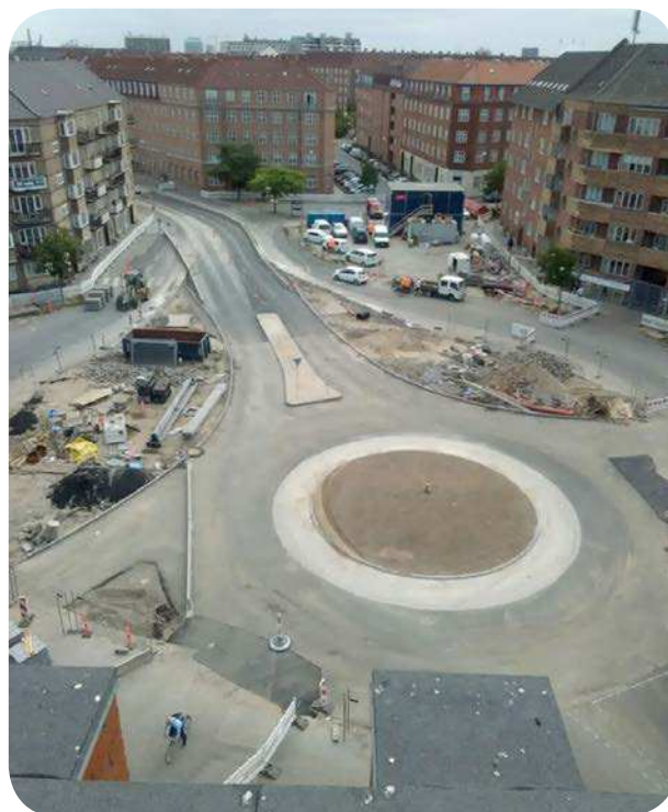
Anlægsarbejde på Skt. Kjelds Plads
