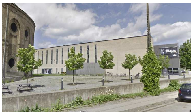
Østre Gasværk Teaterbygningerne set fra Nyborggade.
