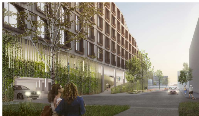
Adgangsvej nord for bebyggelsen set fra øst.
