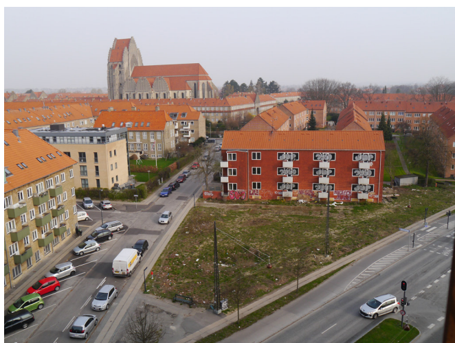
Byggegrunden set fra et nyt parkeringshus på Bispebjerg Hospital. Grundtvigs Kirke dominerer kvarteret. Foto: Vilhelm Lauritzen Arkitekter
