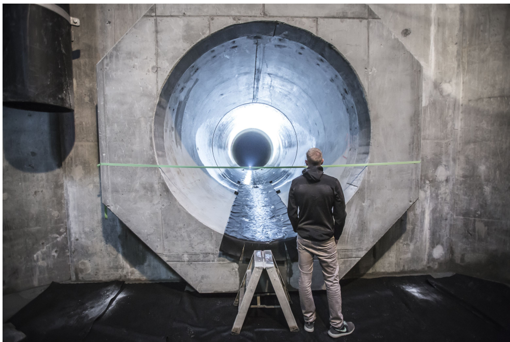
Østerbro skybrudstunnel. Foto: HOFOR
