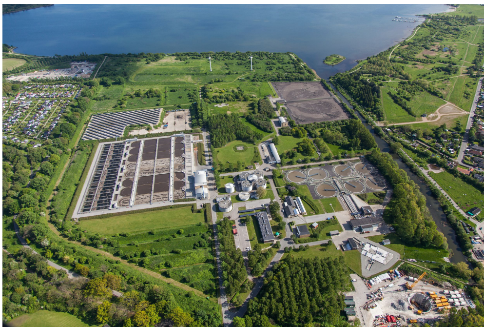
Renseanlæg Damshusåen. Foto: Hviid Photography
