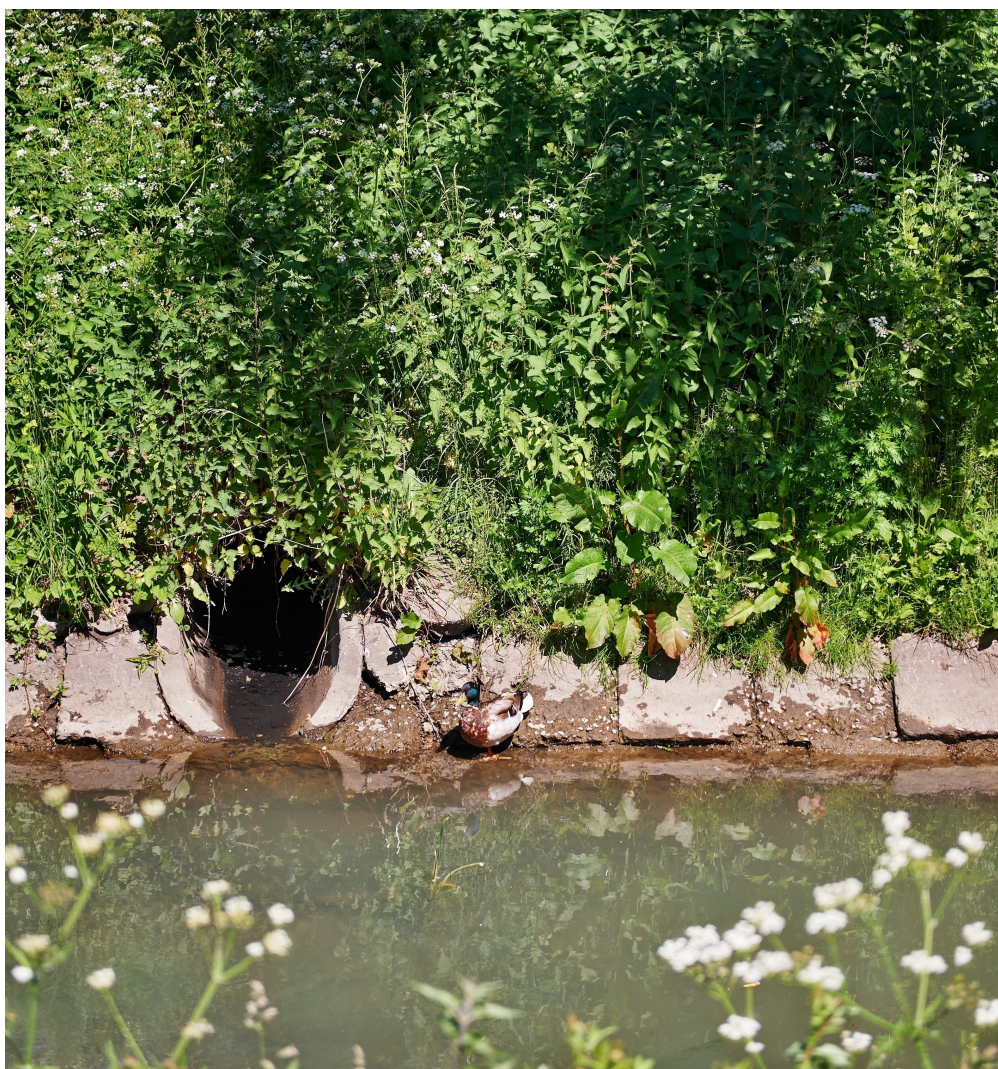
Regnvandsudløb ved Harrestup Å. Foto: HOFOR
