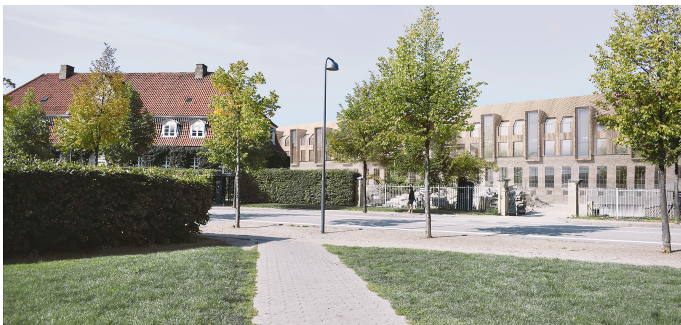
Bygning 25 og Laboratoriebygningen. Illustration: C.F. Møller.
