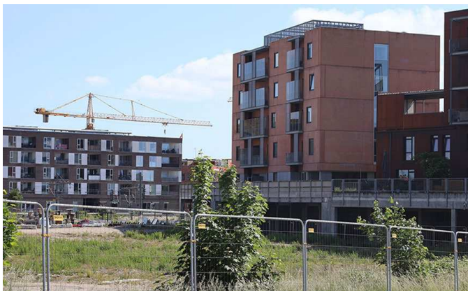
Lokalplanområdet set fra Følager med de eksisterende længehuse til højre med den åbne plint, der bl.a. rummer parkering.
