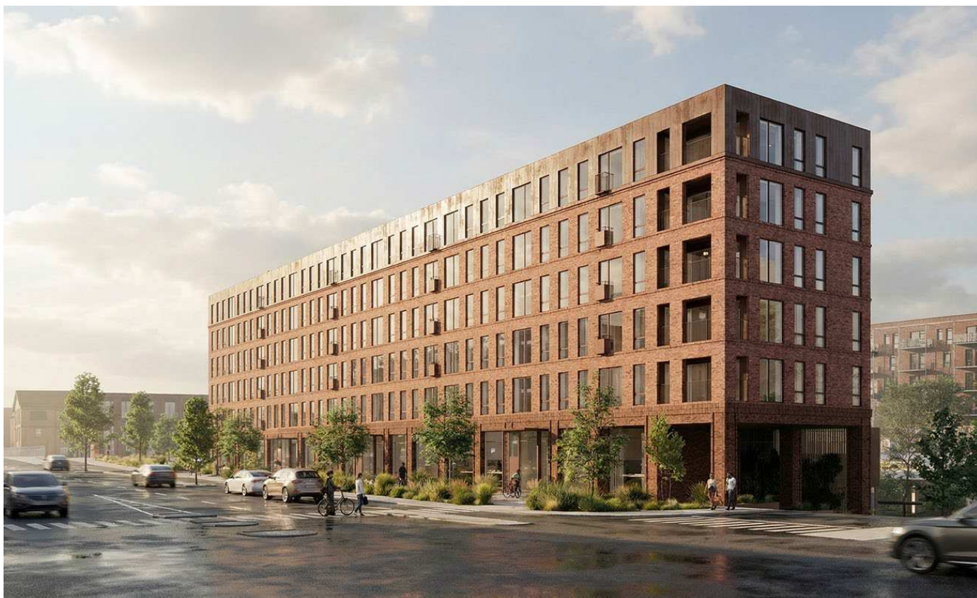
Visualisering, der viser et eksempel på et nybyggeri i overensstemmelse med tillægget til lokalplanen set fra Gammel Køge Landevej ved krydset ved Torveport/Følager. Illustration: Nordic Office of Architecture.
