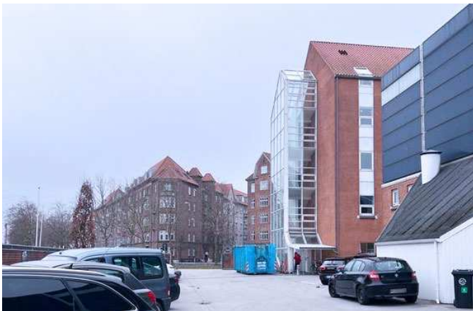
Foto, der viser den bygning der nedrives.
