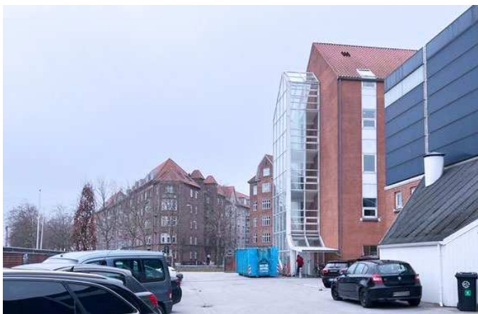
Foto, der viser den bygning der nedrives.
