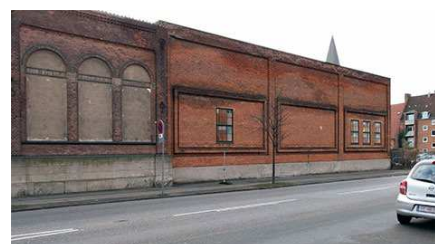
Tagensvej 85 – Spinderibygning II.
